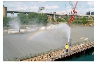
Imagen 25: Riego del hormigón para el curado.
