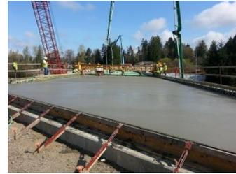
Imagen 23: Fraguado del hormigón.
