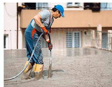
Imagen 22: Vibrado del hormigón.
