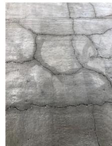
Imagen 24: Retracción del hormigón.
