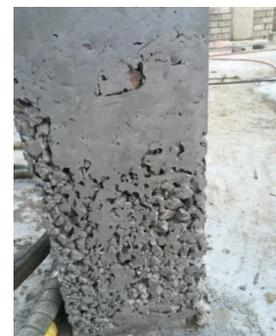
Imagen 27: Coqueras en un pilar de hormigón.
