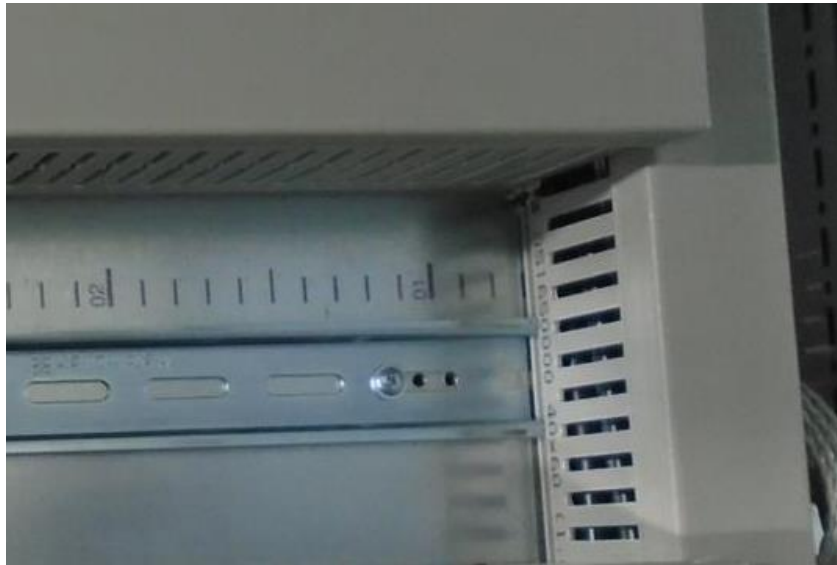
Figura 24. Agujeros de fijación para canaletas y carriles.
