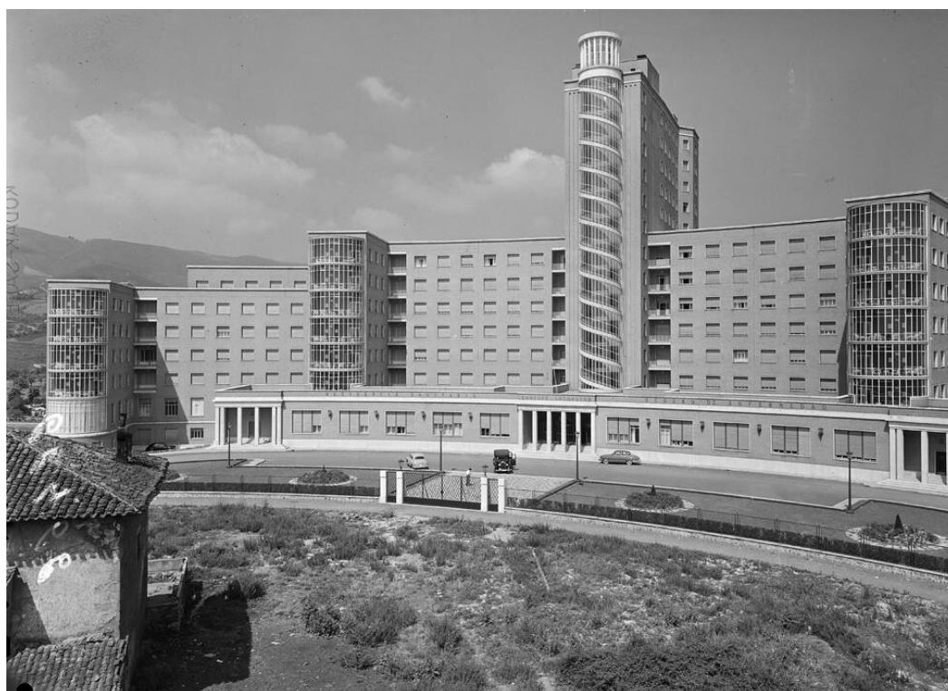
Fig 16. Residencia Sanitaria Enrique Sotomayor en 1955. Ministerio de Cultura – Fondo Juan Miguel Pando Barrero. Proyecto fotográfico "Historia de Bilbao a través de la fotografía" de Jon Arregi. [Imagen disponible en: https://www.flickr.com/photos/jonarregi/48972251088/in/album-72157648248841908/ ]
