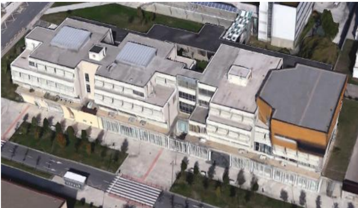
Figura 4.1. Fotografía aérea del exterior del edificio bajo estudio.
