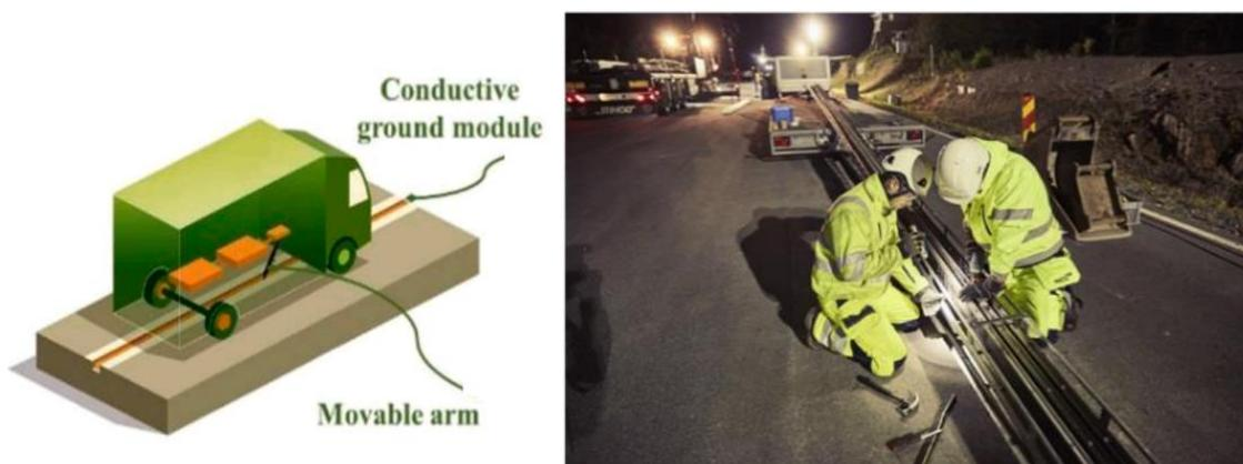
Fig. 3. Sistema de recarga mediante railes. [2] y [3] respectivamente.
