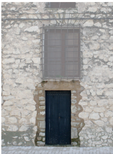
Fig. 51. Puerta al sótano abierta en la fachada noreste.
