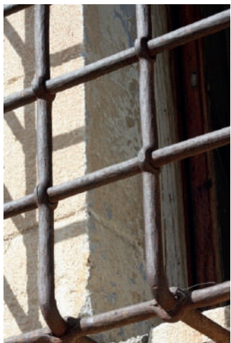
Fig. 39. Detalle de la forja.
