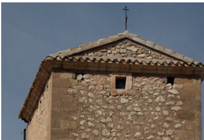
Fig. 47. Hastial sobre fachada sureste.
