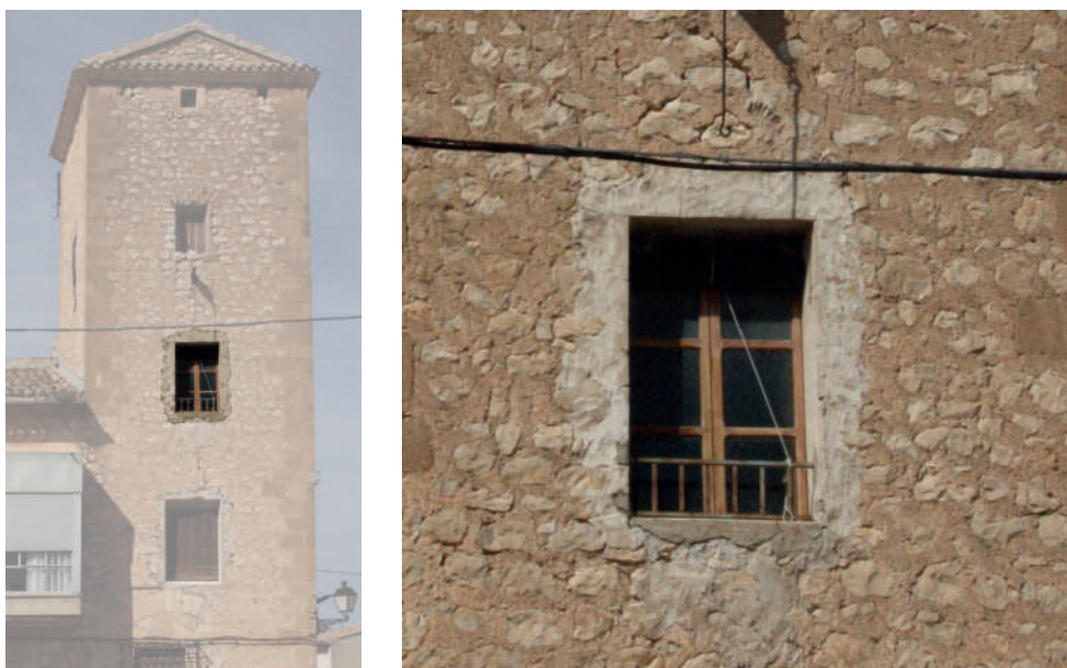
Fig. 56. Vano de la tercera planta de la torre en su fachada sureste.
