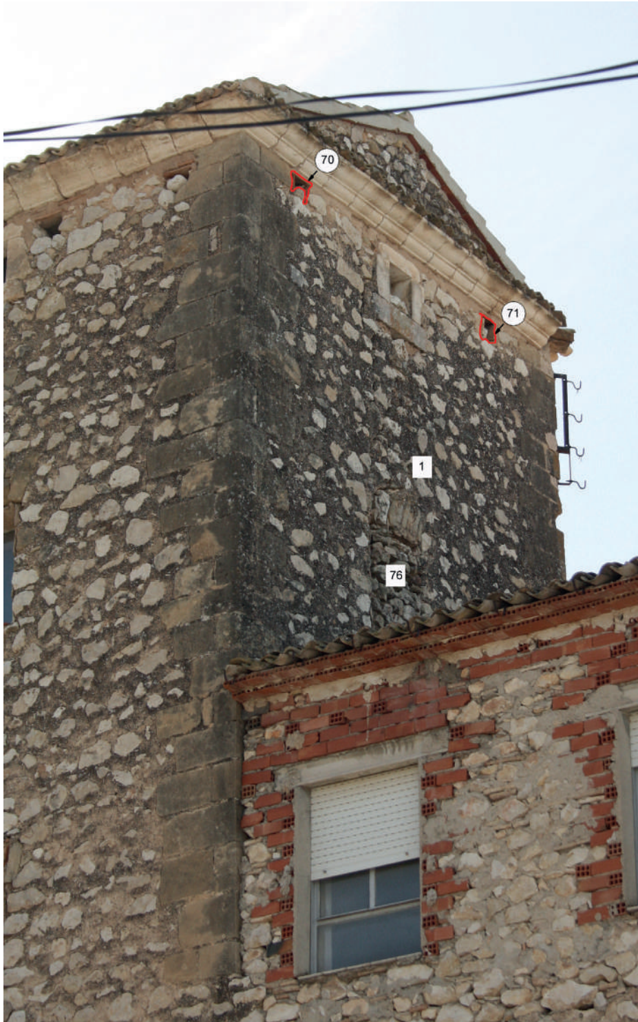
Fig. 26. Registro gráfico de las unidades estratigráficas de la fachada norte de la torre.
