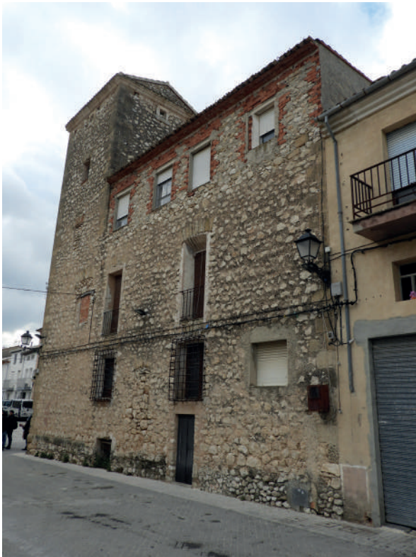
Fig. 17. Fachada noreste sobre calle Mayor.
