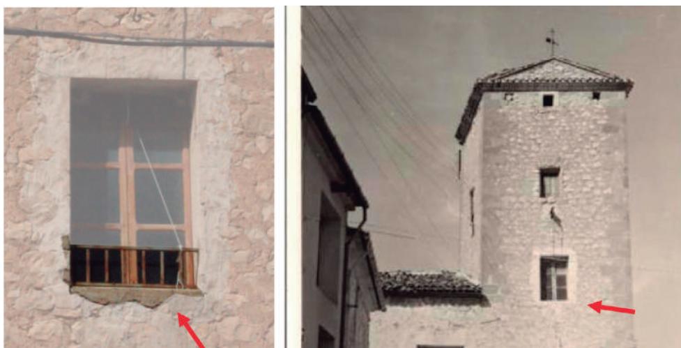
Fig. 57. Detalle de la barandilla y fotografía previa a su colocación.
