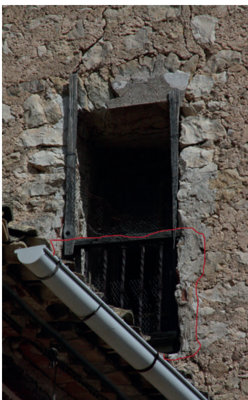
Fig. 58. Barandilla en la ventana del cuarto nivel de la torre en la cara suroeste.
