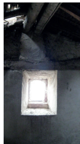
Fig. 48. Imagen interior de la cubierta.
