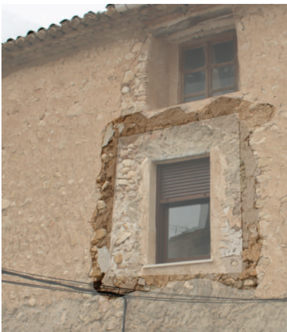
Fig. 60. Ventana de la tercera planta de la fachada principal
