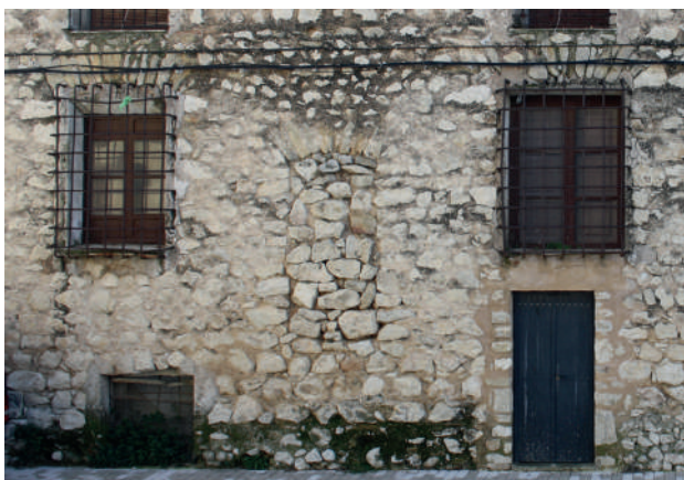
Fig. 38. Rejas en ventanas de fachada noreste.
