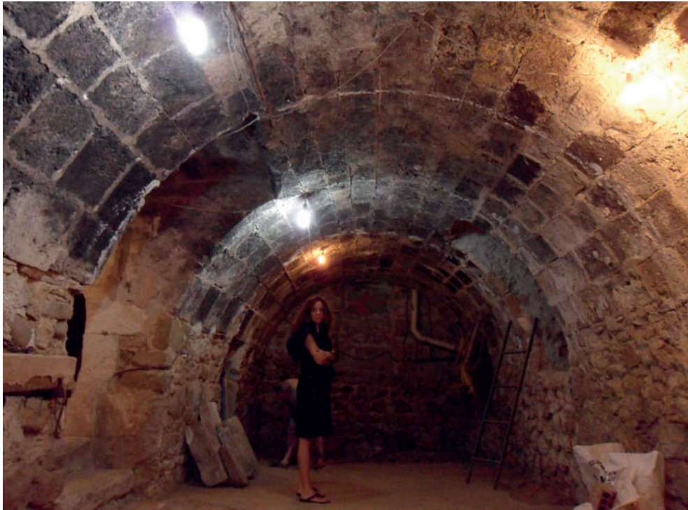
Fig. 82. Teresa Aracil Gadea y Celeste Serra Aracil, propietarias de una de las alas del edificio mostrándonos su interior.
