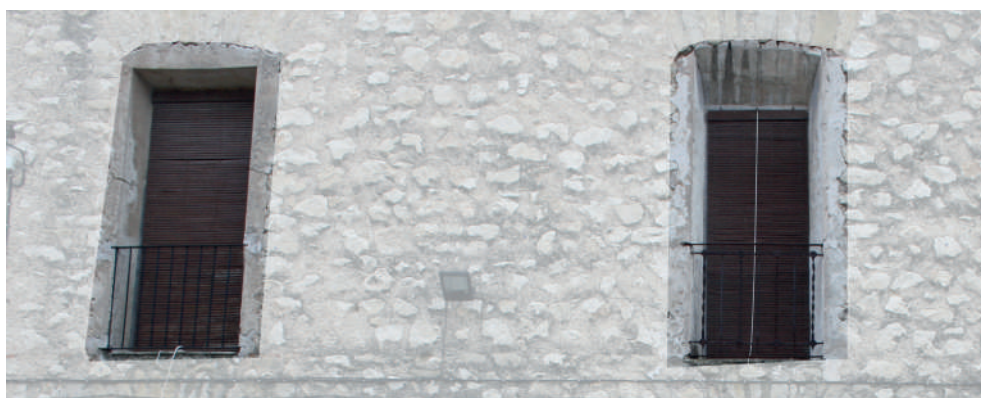
Fig. 46. Ventanas ubicadas en el segundo nivel de la fachada noreste.
