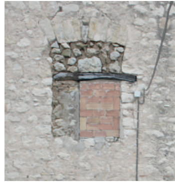
Fig. 44. Reducción del vano de la ventana del primer nivel de la cara noroeste.
