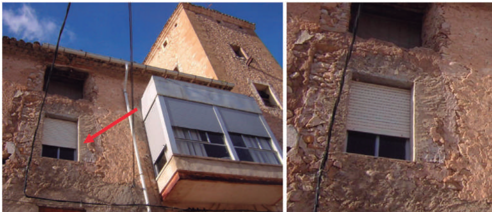
Fig. 62. El mismo vano en 2009.
