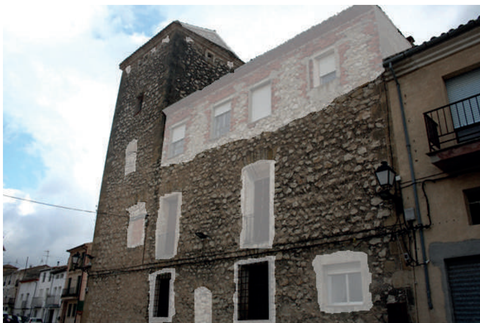
Fig. 34. Imagen general de la fachada noreste
