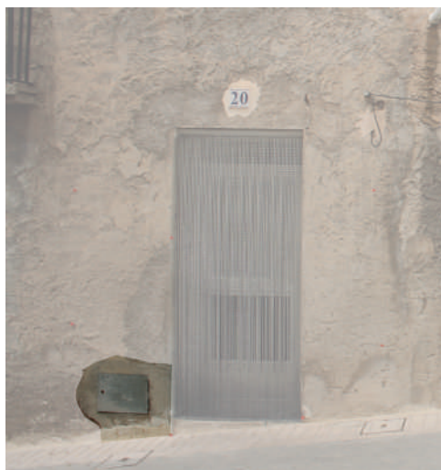
Fig. 70. Apertura de hueco para tapa de registro en la fachada sureste.
