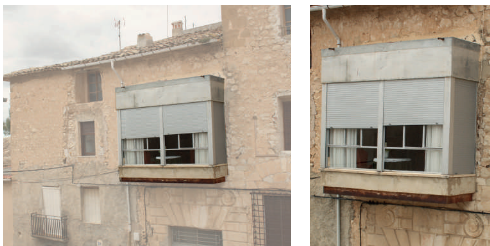
Fig 72. Mirador de aluminio en la fachada principal.
