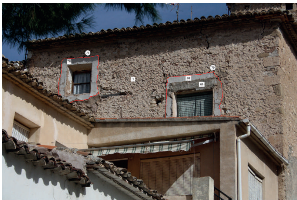
Fig. 24. Registro gráfico de las unidades estratigráficas de la parte visible de la fachada occidental del palacio.
