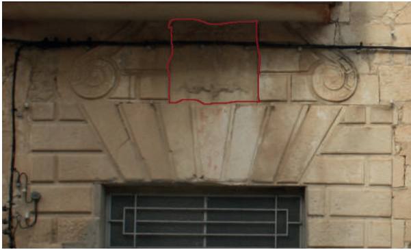
Fig. 43. Picado del escudo sobre la puerta principal.
