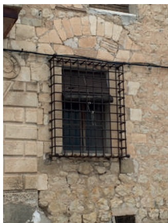
Fig. 37. Reja en la ventana de la fachada sureste.
