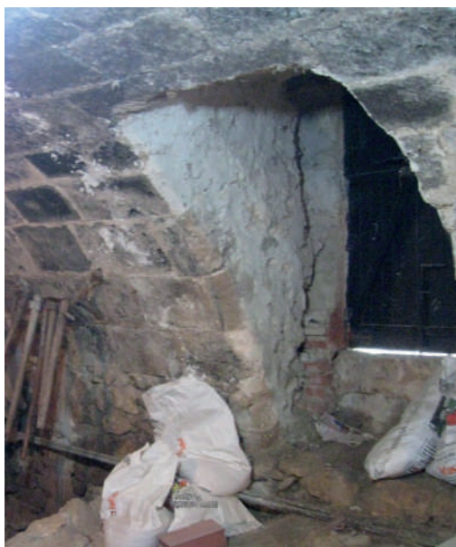
Fig. 52. Imagen de la puerta tomada desde el interior del sótano.
