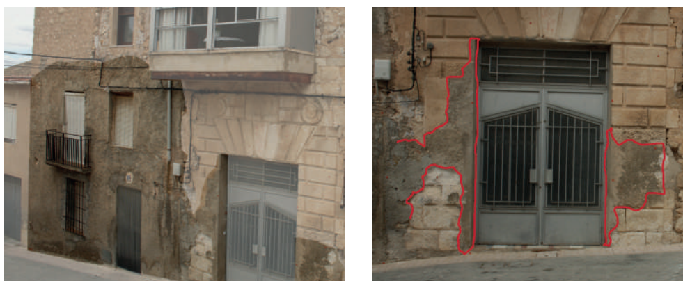
Fig. 63. Vista general y detalle del enfoscado de cemento sobre la fachada principal.
