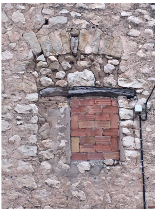
Fig. 66. Ventana cegada con ladrillos cerámicos industriales en el primer nivel de la cara noreste.
