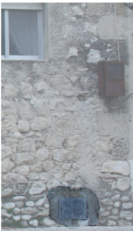
Fig. 71. Colocación de tapa de registro en la fachada noreste.
