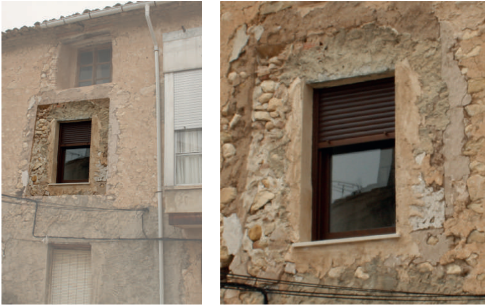
Fig. 61. El vano de la ventana en 2016.
