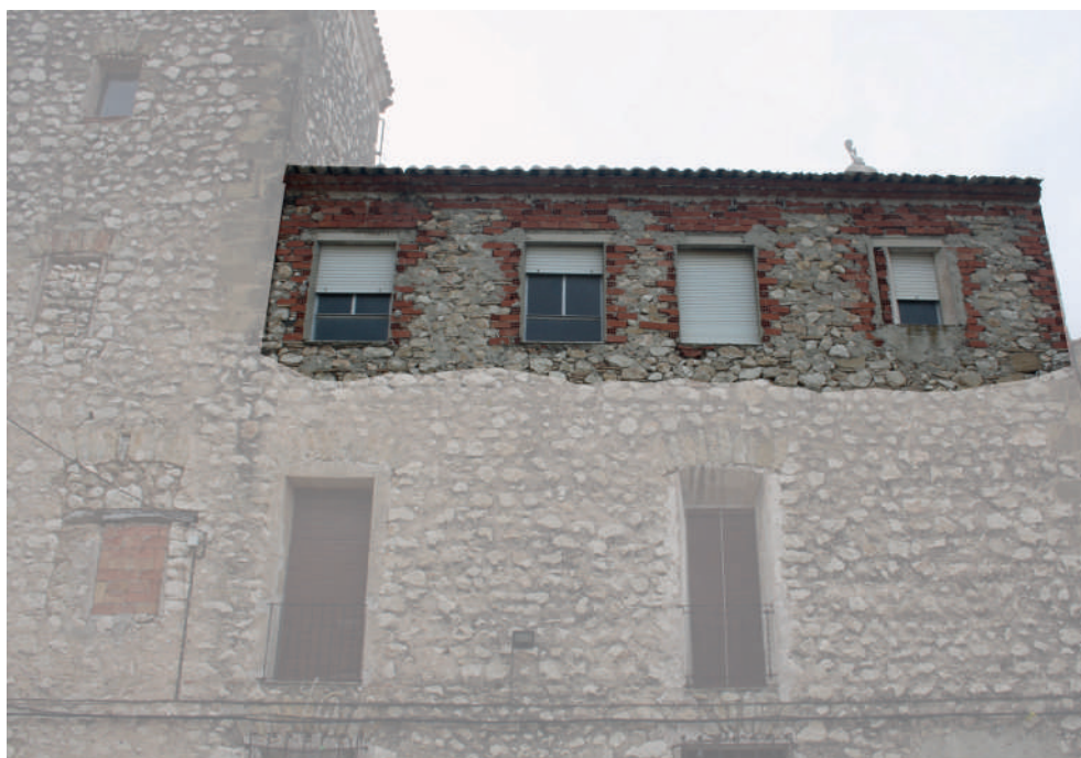
Fig. 68. Nueva planta en el ala noreste del palacio.
