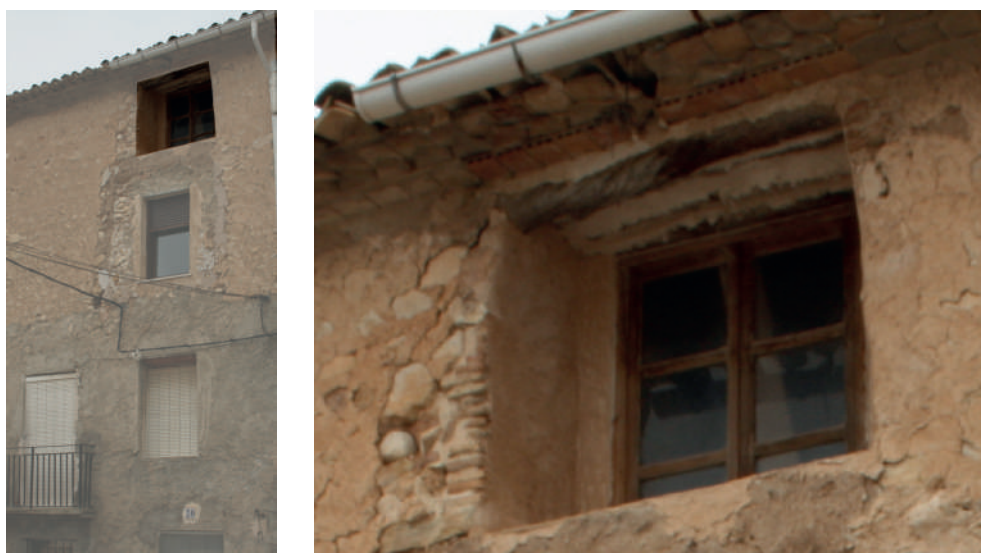
Fig. 59. Ventana de la cuarta planta de la fachada principal.
