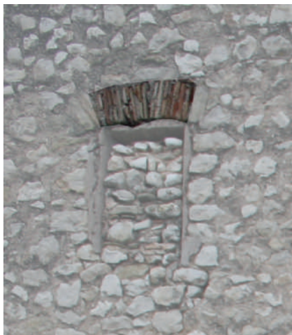
Fig. 40. Ventana del segundo nivel de la cara noreste de la torre con el dintel de ladrillos cerámicos.
