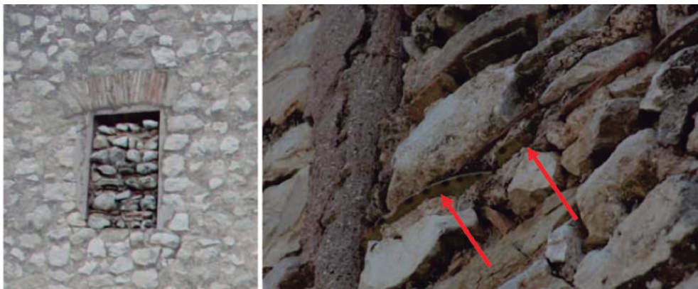
Fig. 45. Ventana cegada en el segundo nivel de la torre y detalle de los fragmentos cerámicos integrados en el relleno de mampuestos.
