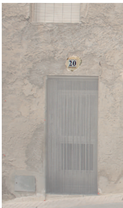
Fig. 65. Placa de numeración sobre la puerta de la fachada sureste.
