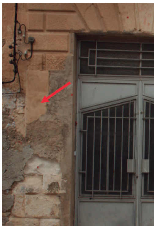
Fig. 64. Detalle del enlucido en la fachada principal.
