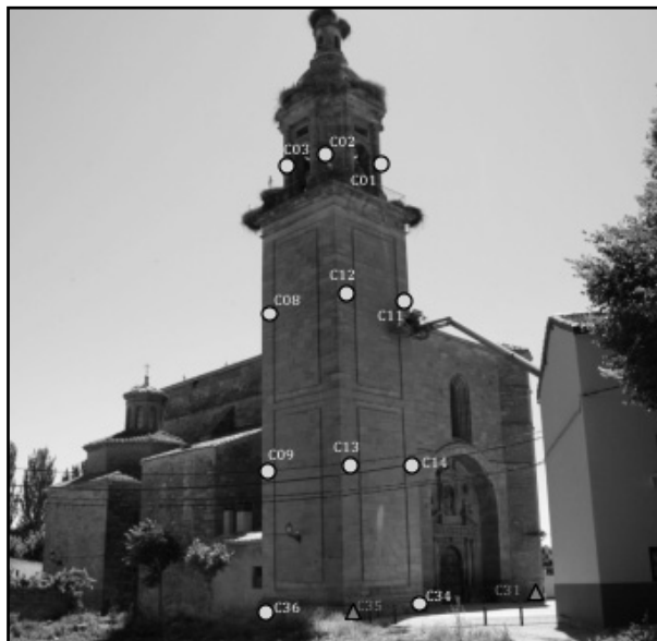
Figura 1. Localización de las señales de la torre. Las señales C31 y C35 definen el sistema de referencia. Figure 1. Placement of the targets on the tower. Points C31 and C35 define the reference system.
