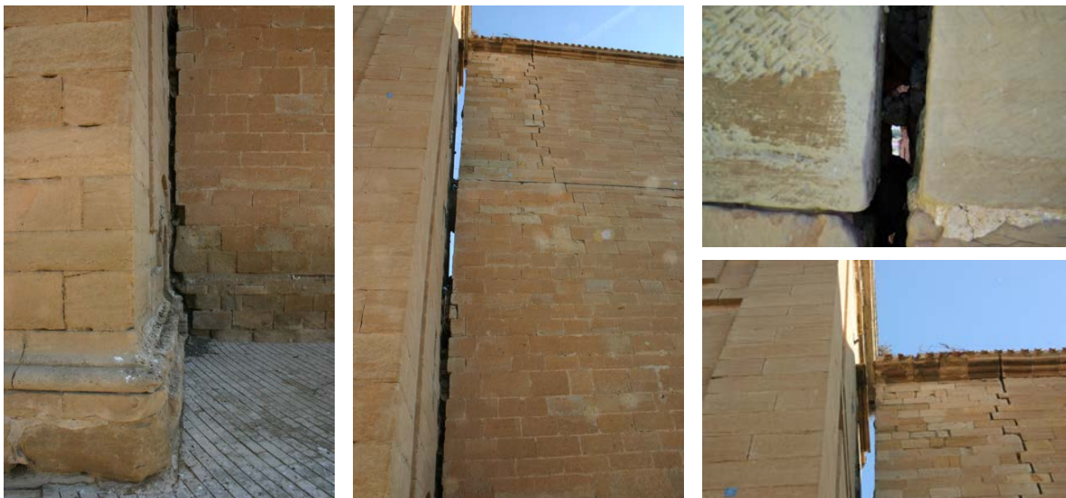
Figura 9. Ejemplo de fotografías convencionales de las diferentes patologías tal como se presentan actualmente.
