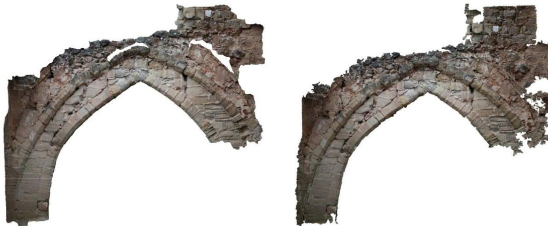
*Imagen 6.14: Ortofoto Arco Image Master (izquierda) y ortofoto Arco Photomodeler (derecha).*
