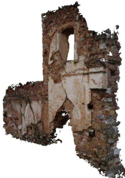
*Imagen 6.12: Modelo del muro "R" obtenido por Photomodeler (vista 2)*
