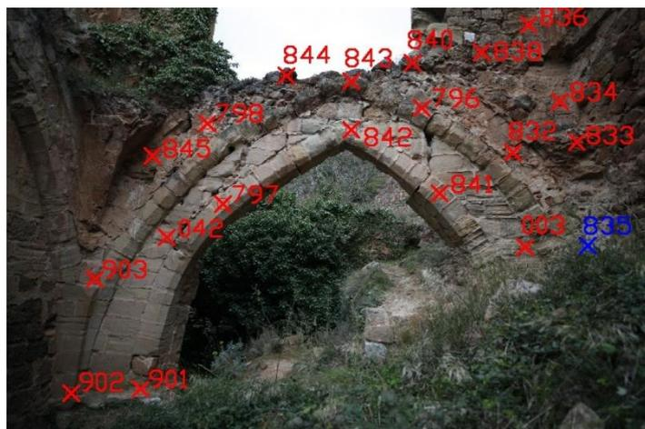
Imagen 6.22: Croquis de los puntos de control del Arco
