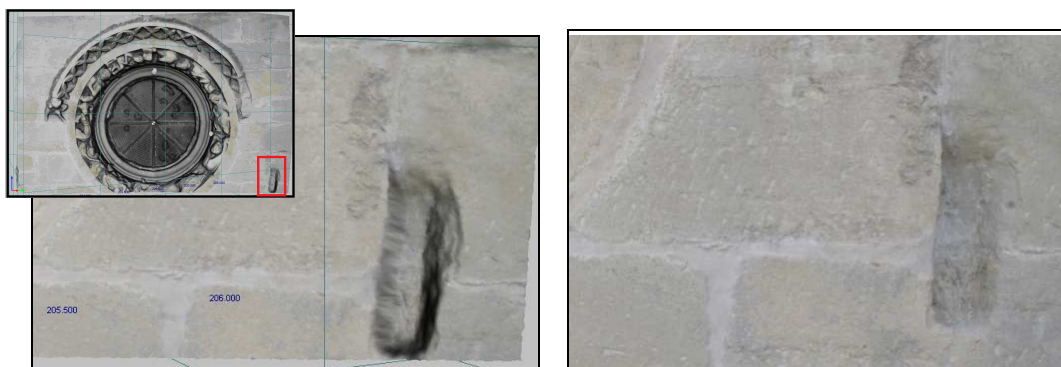
Figura 5.25. Imagen en detalle de la hendidura de la parte inferior derecha del rosetón.
