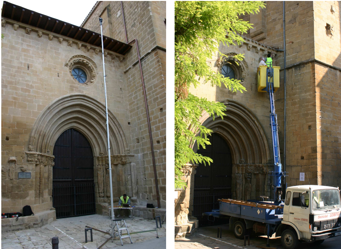
Jalón telescópico (izq.) y grúa utilizadas(dcha.).
