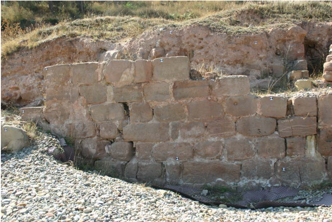
Fig. 6.- Muro oeste de la excavación en el que se han situado las dianas que sirven de puntos de apoyo para la rectificación de texturas.
