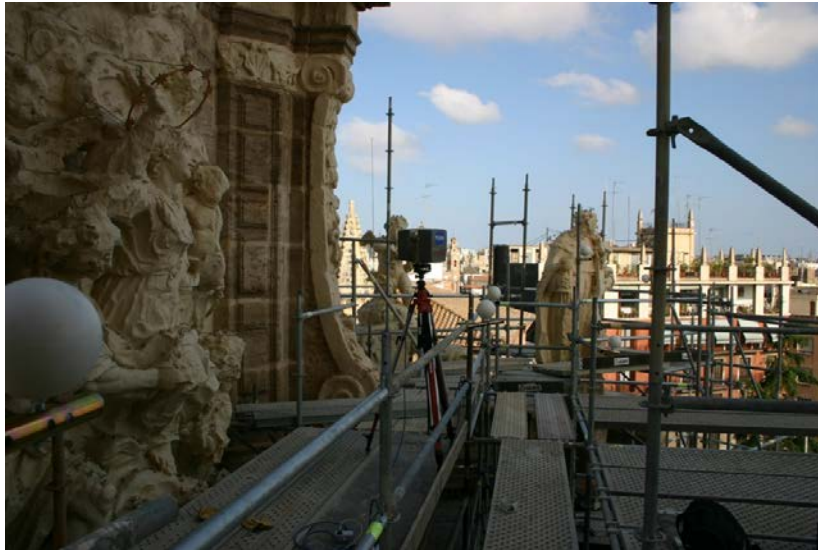
Fig. 8.- Escáner durante el barrido, se pueden apreciar algunas de las esferas distribuidas por toda la vuelta de horizonte.
