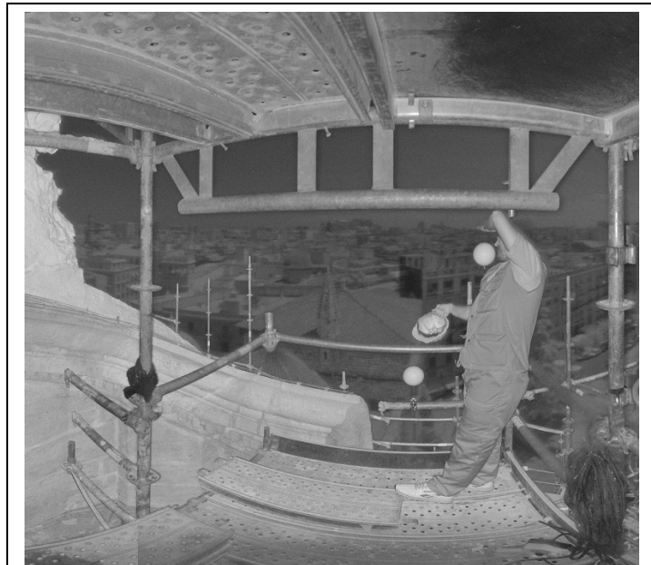
A5.3.- Evitando la iluminación solar directa sobre las esferas utilizadas para la orientación de los barridos.
