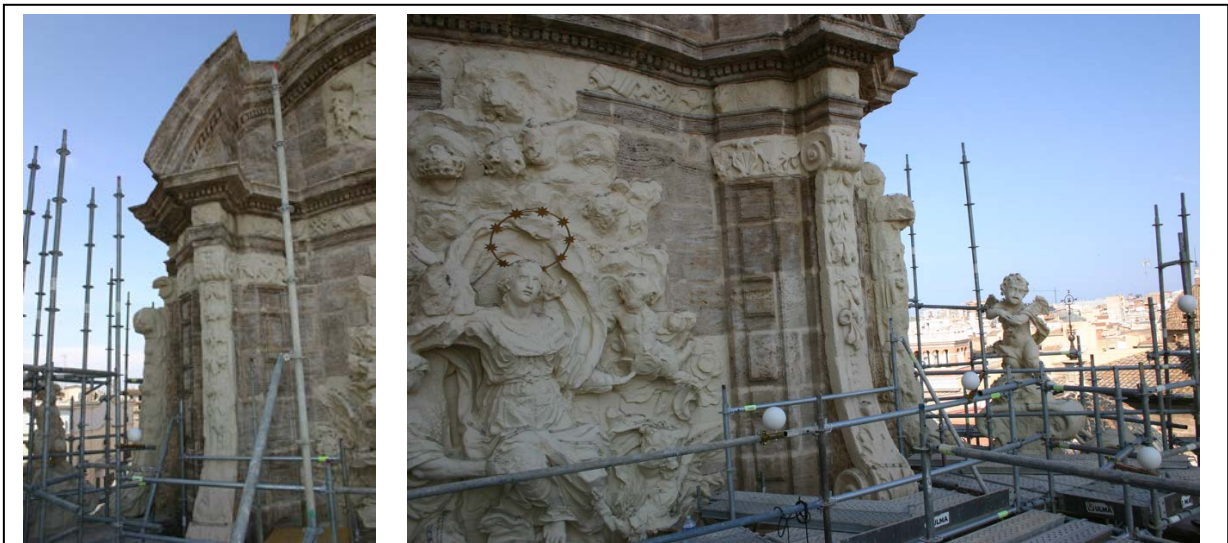
Fig. 2.- Ejemplos de fotografías tomadas en campo, en las que se aprecian las ocultaciones y mala geometría debido al poco alejamiento disponible.
